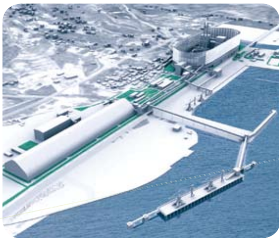
La centrale elettrica di Saline Joniche: in primo piano il nuovo molo per le navi carboniere, a sinistra il carbonile, completamente coperto, a destra la centrale.
