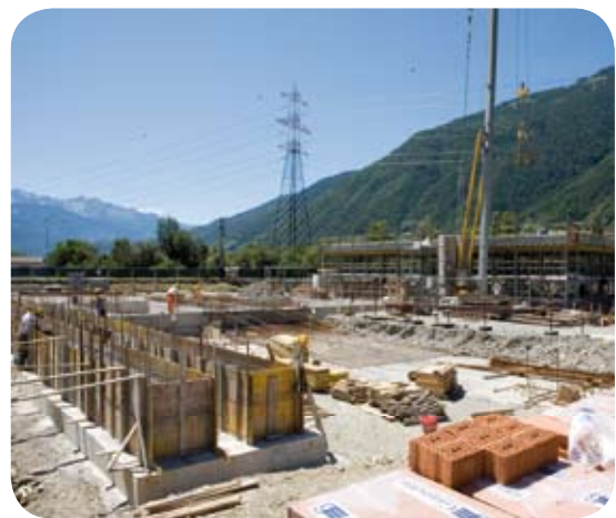
Il cantiere della merchant line a Tirano: un investimento nello scambio transfrontaliero di energia.
