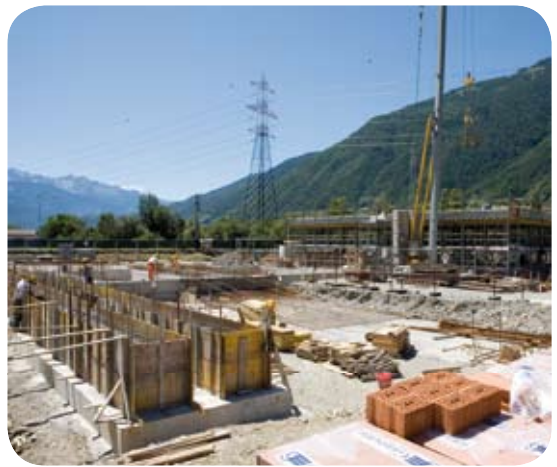
Investition in den grenzüberschreitenden Stromaustausch: In Tirano haben die Bauarbeiten begonnen.
