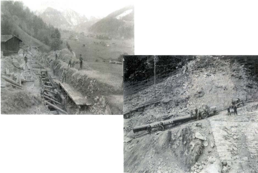
Bau der Druckleitung Schlappin - Klosters Dorf 3. November 1927
