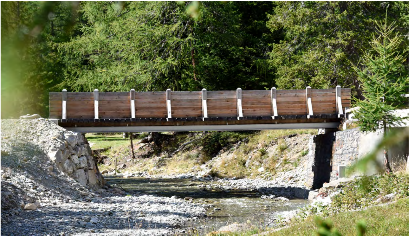
Die neu gebaute, höher gelegene Brücke vermeidet Abbaggerungen und die damit verbundene Zerstörung der Uferhabitate.
