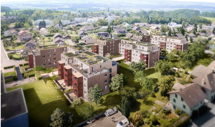
Abbildung 12: Siedlung Sentmatt, Obfelden: Der Strom aus den Hybridkollektoren wird für den Betrieb der Wärmepumpe und für den Allgemeinstrom im Eigenverbrauch genutzt. Bildquelle: Halter Immobilien AG
