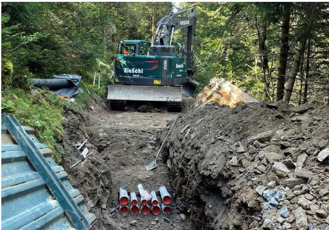
Bei Laax ersetzt eine leistungsstarke, erdverlegte Kabelleitung die bestehende Freileitung.
