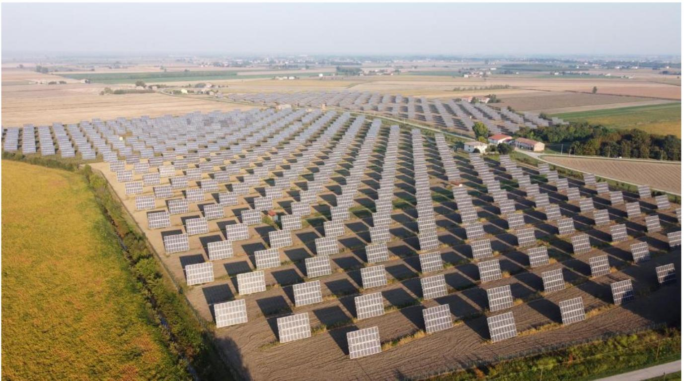
Die Photovoltaikanlage in Castelguglielmo wurde mit effizienteren bifazialen Modulen ausgerüstet.
