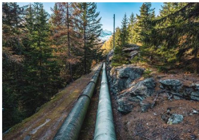
Das Kraftwerksgebäude Robbia wird komplett ausgehöhlt und die zwei Rohre der Druckleitung Balbalera werden durch ein einzelnes grösseres Druckrohr ersetzt.
