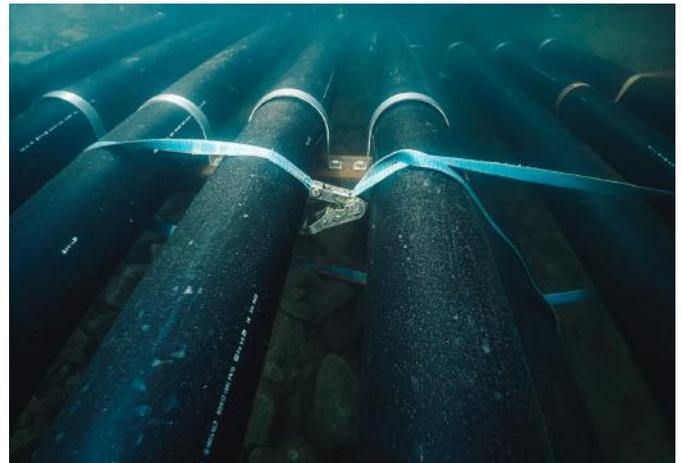
Die Kabelschutzrohranlage wird zuerst an der Oberfläche des Sees geführt, bevor sie im Beisein von Profitauchern auf den Grund des Sees abgesenkt wird.
